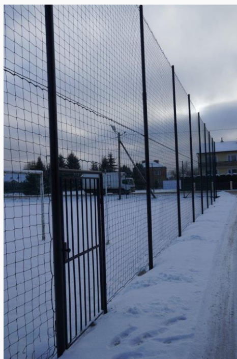
Zdj. 23,24. Odremontowana siatka na stadionie w Siedlance 2021
